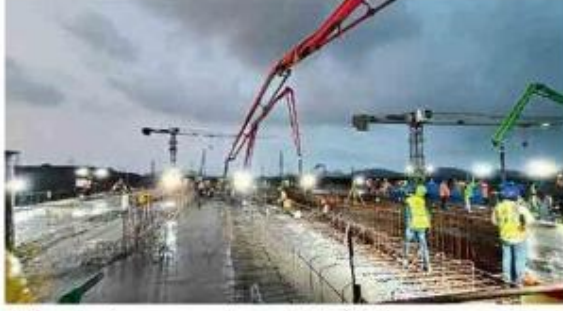
मुंबई : बुलेट ट्रेन प्रकल्पाच्या लेव्हल स्लॅबचे काँक्रीटीकरण करण्यात आले.
